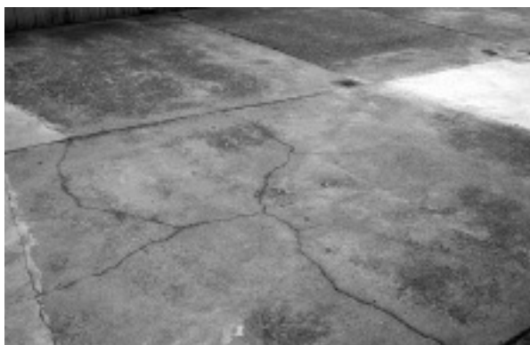
Fessurazione di origine termica in una pavimentazione in calcestruzzo
