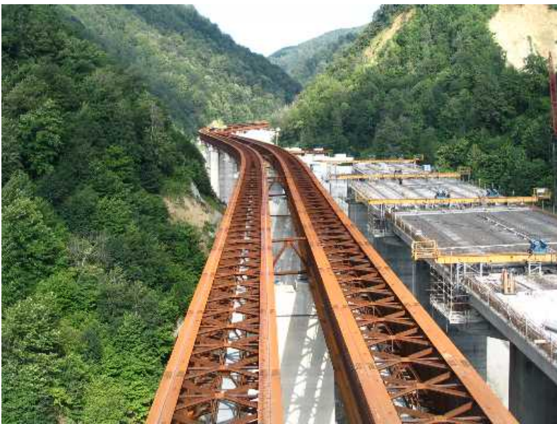
Sviluppo delle travate per l'impalcato
