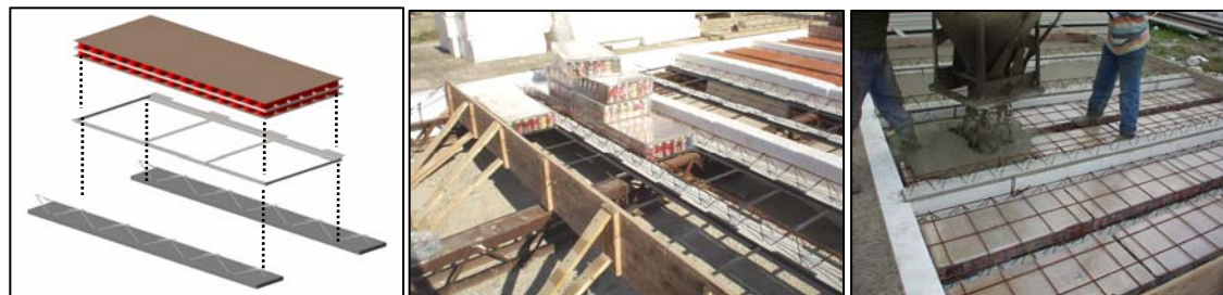
Figura 12. Fasi di posa dei travetti, cestelli e pignatte. Getto del calcestruzzo alleggerito strutturale.
