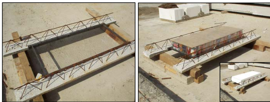
Figura 11. Cestello porta-pignatte in metallo con bordo sagomato per l'appoggio ai travetti e rete metallica sul fondo per consentire l'intonaco all'intradosso del solaio. Consente anche l'impiego di lastre in polistirolo espanso non sagomate.
