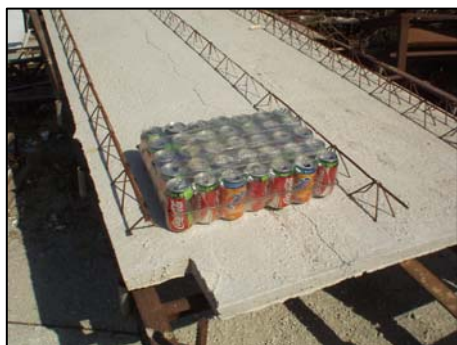
Figura 06. Primo tipo di pignatta con lattine d'alluminio.
