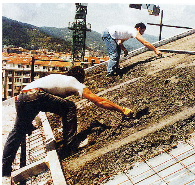
Fig. 9 - La realizzazione di un massetto.
